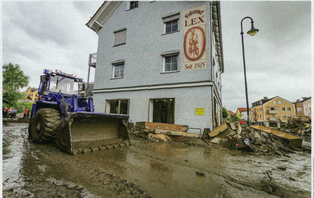
Nach Unwetter und Starkregen im Frühsommer 2016 kamen bei den Aufräumarbeiten vielerorts die Bergeräumgeräte des THW zum Einsatz.
